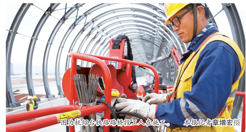
图为杭绍台铁路路桥段工人在施工。本报记者章增宏摄
