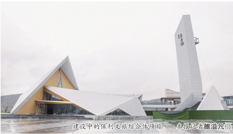
建设中的保利文旅综合体项目。本报记者 董溢凡 摄
