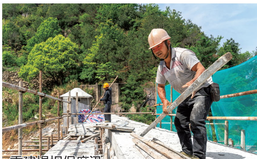
重建堤坝保度汛
