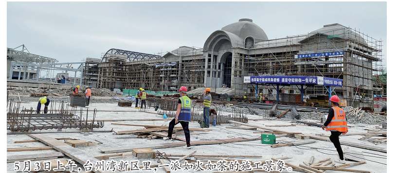
5月3日上午,台州湾新区里,一派如火如荼的施工景象。
