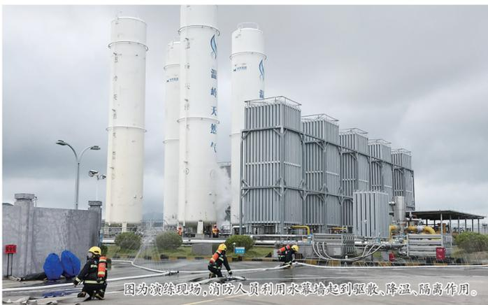
图为演练现场,消防人员利用水幕墙起到驱散、降温、隔离作用。
