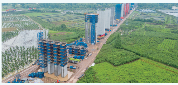
杭温高铁仙居特大桥
