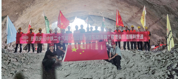
2020年9月30日,前期工程渡头隧道顺利贯通
