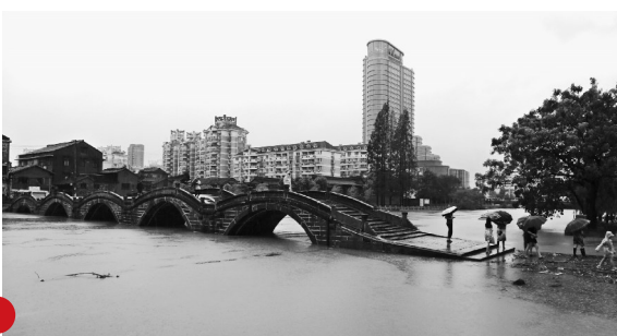
修复后的五洞桥
