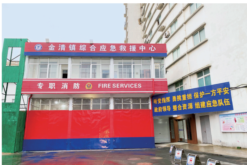
金清镇综合应急救援中心
