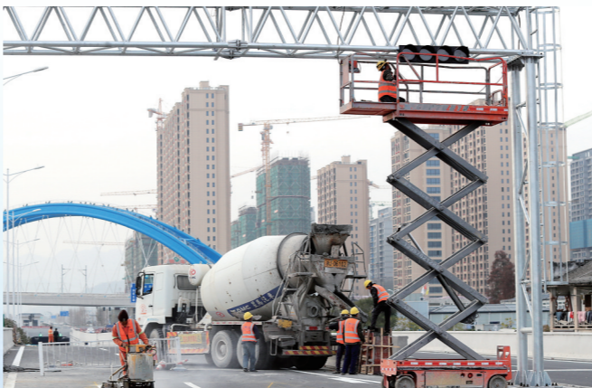
工人在安装情报板门架
