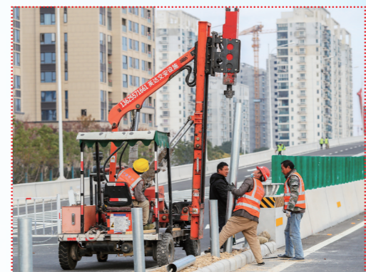
工人在波形护栏打桩
