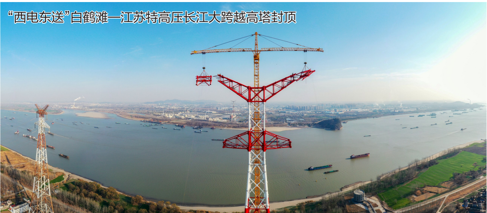
12月26日拍摄的长江大跨越输电钢管塔封顶施工现场(无人机照片)。当日,位于安徽马鞍山长江边的白鹤滩—江苏±800千伏特高压直流输电工程长江大跨越输电钢管塔封顶。这座输电钢管塔高278.2米,经过建设者60余天的奋战成功封顶。白鹤滩—江苏±800千伏特高压直流输电工程是我国“西电东送”战略的重点工程,是促进国家能源结构调整和节能减排的清洁能源项目。工程投运后,每年输送电力将超过312亿千瓦时。
