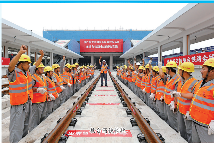
杭台隧道内铺轨作业
