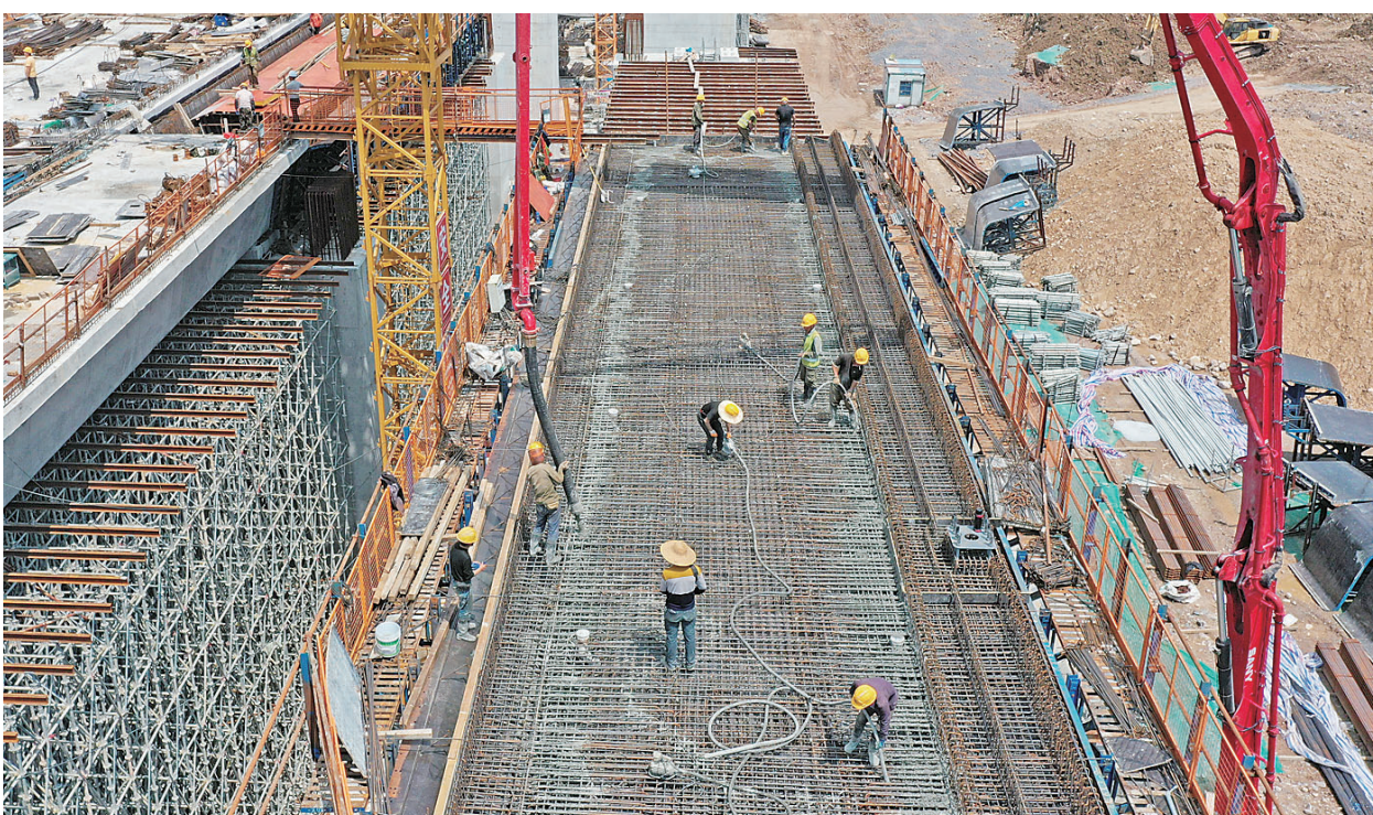
杭温铁路仙居特大桥施工正酣
