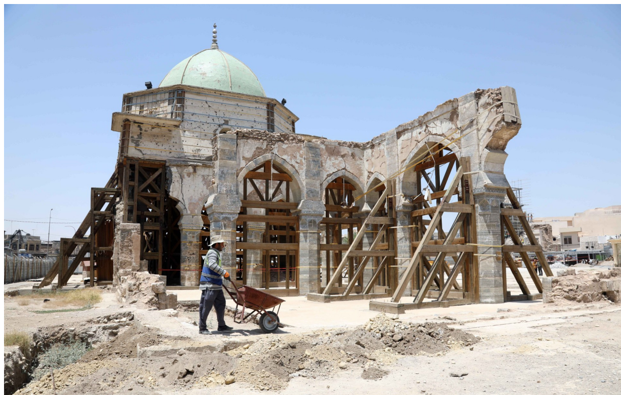
7月3日,工人在伊拉克摩苏尔老城参与努里清真寺的修复施工。
