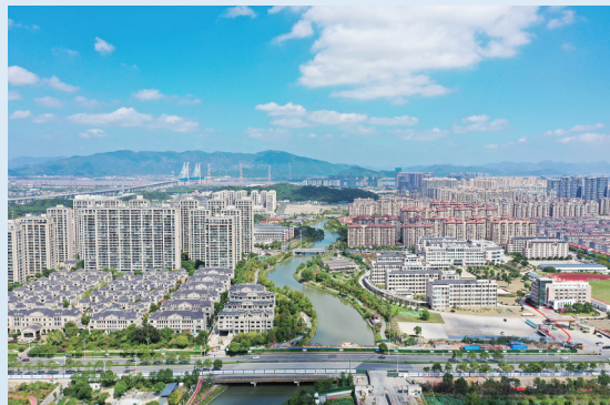
椒江区永宁河(栅浦闸-高闸浦)
