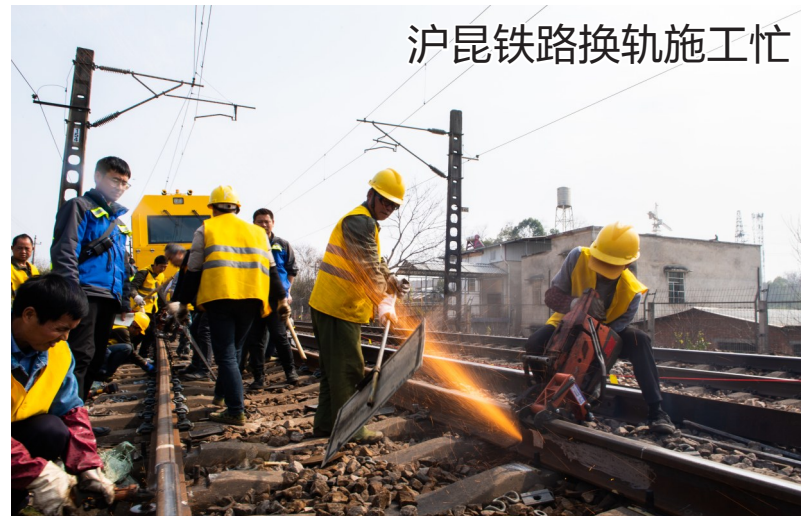
2月19日,在沪昆铁路娄底至湘潭东区间,铁路工人在铺轨。 近日,在沪昆铁路娄底至湘潭东区间,广铁集团广州工务大修段工人在不影响线路运行的情况下,抓紧时间对线路进行换轨施工,本次施工预计3月底完工。 新华社记者陈思汗摄
