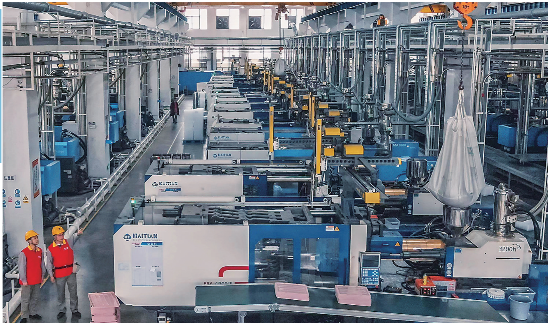
国网台州市黄岩区供电公司为企业量身定制供电方案。台传媒通讯员冯静摄
