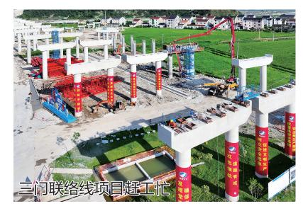
7月11日,在甬台温高速至沿海高速三门联络线项目的健跳互通高架枢 纽施工现场,工人们顶着烈日赶工期。目前4个标段近3000名工人投入紧张的 施工中,部分标段24小时不停工,全线9座隧道全部进洞爆破,桥梁工程、路基 工程施工全面铺开,全线 T 梁预制生产已进入全面提速阶段,全线桥梁桩基施 工已完成近半。据了解,项目建成后,三门将形成两纵一横的日型高速公路网, 实现全县乡镇10分钟内上高速。 台传媒记者孙金标摄
