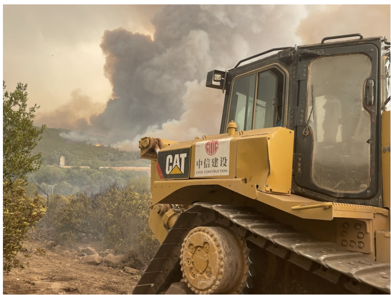
在阿尔及利亚塔夫省的山火现场,“84公里项目”工作人员用工程机械在森林中设置防火隔离带(2022年8月18日报)。新华社发(中信建设供图)
