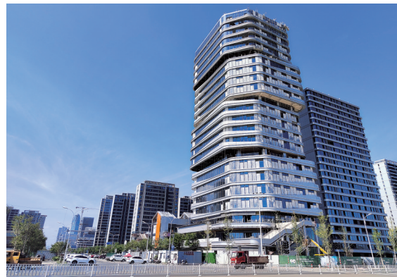
正在进行室内装修和幕墙施工的双创中心。
