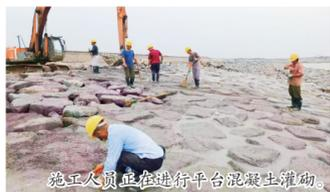
施工人员正在对平台混凝土灌砌。
