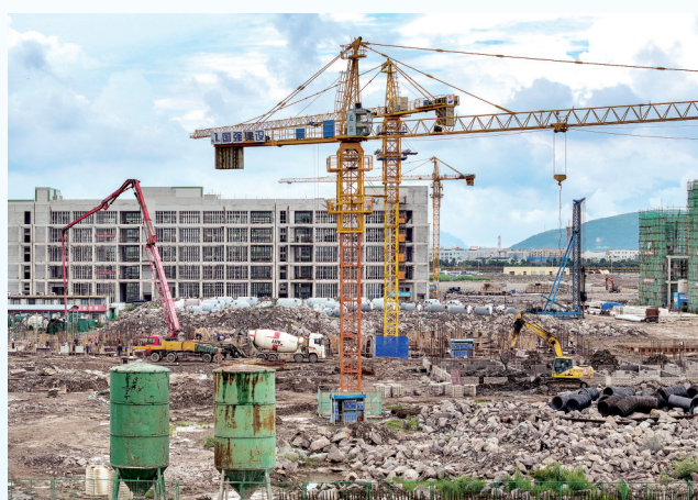
南洋医化园区内,项目建设正酣
