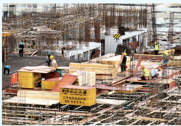
建设中的康居工程二期
