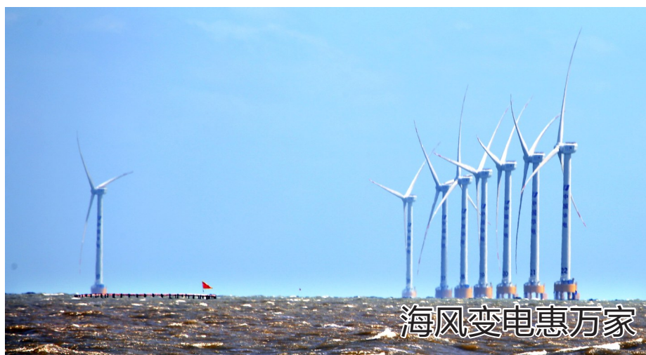
10月24日，在玉环市隘滩湾海域上的华电玉环1号海上风电场，22台大“风车”正将风能转化为电能，通过国家电网点亮千家万户。近年来，玉环市加快建设新型电力系统，推动“风光倍增”，实现当地经济效益和生态效益双丰收。
