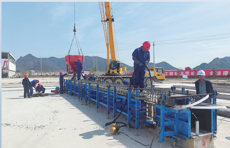
三门梁场T梁混凝土浇筑。
