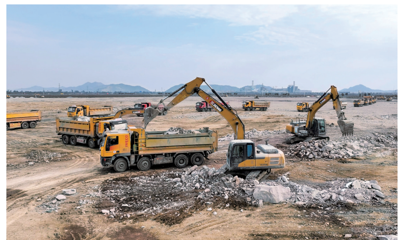
重大产业项目开工
