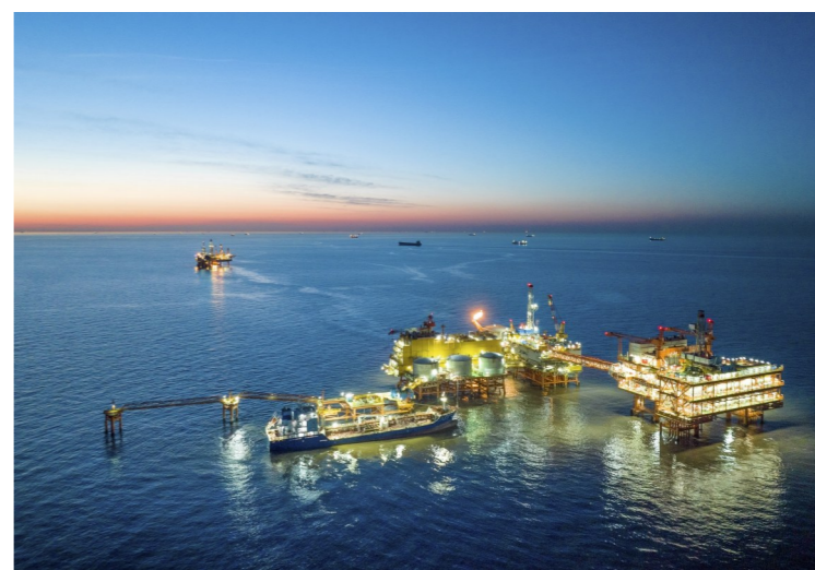
这是2024年1月25日拍摄的埭北油田全景(无人机照片)。当日,位于渤海湾西南部的埭北油田油气处理与岸电设备共建平台——CEPC(中心平台)正式投产,该平台可使油田接入来自陆地的绿色电力,减少海上“自发电”带来的天然气和原油消耗。 新华社发(杜鹏辉摄)
