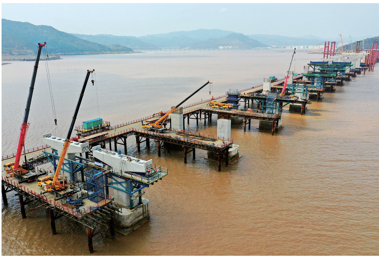
台州1号公路西沙门大桥施工正酣
