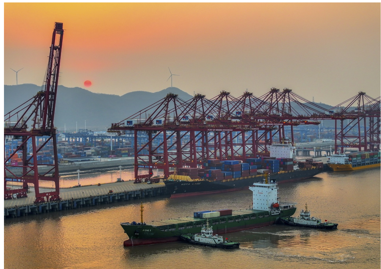
浙江宁波舟山港金塘港区码头作业繁忙(2024年2月11日摄,无人机照片)。
