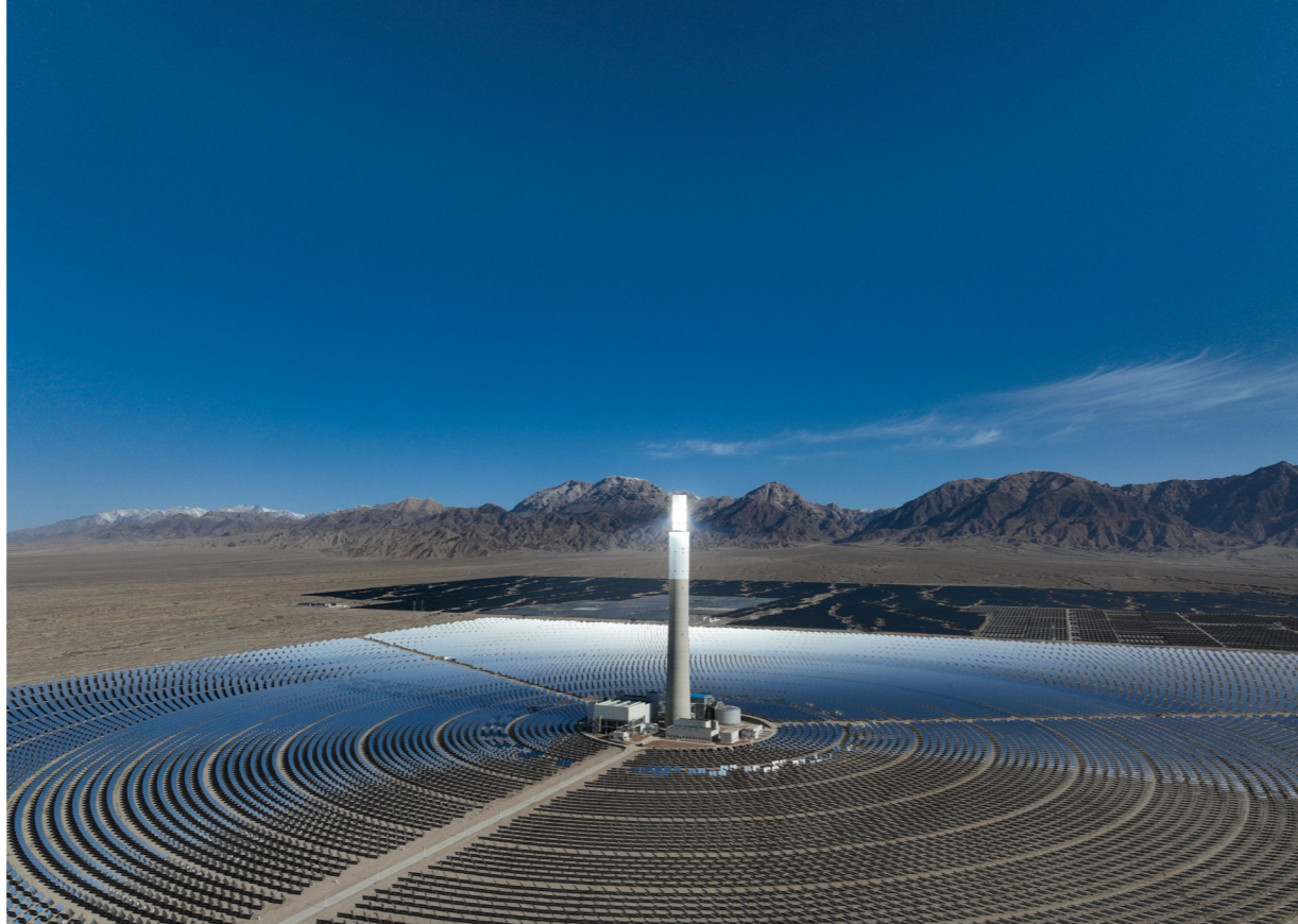
在青海省海西蒙古族藏族自治州德令哈市光伏(光热)产业园拍摄的光热电站(2024年4月23日摄,无人机照片)。 新华社记者张 龙摄
