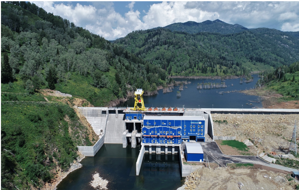
这是2021年7月28日拍摄的哈萨克斯坦图尔古孙水电站(无人机照片)。
