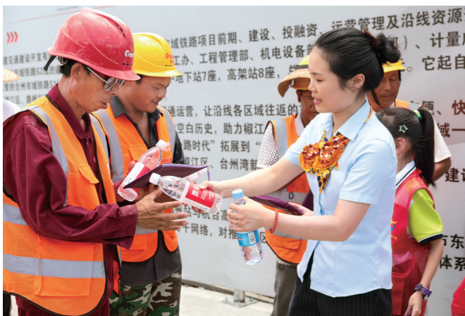
为市域铁路S2线上的建筑工人送水。
