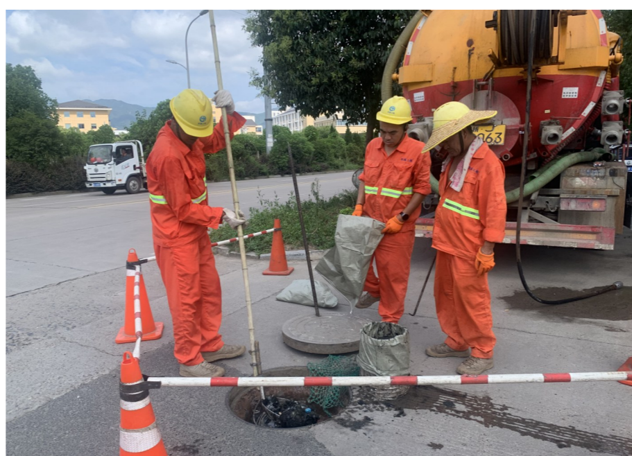
曾建平(中)正在和同事一起清理污水井。
