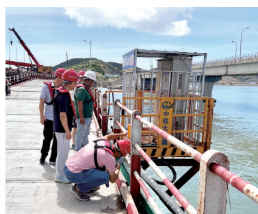
人保财险台州市分公司对工程设施开展防灾检查。
