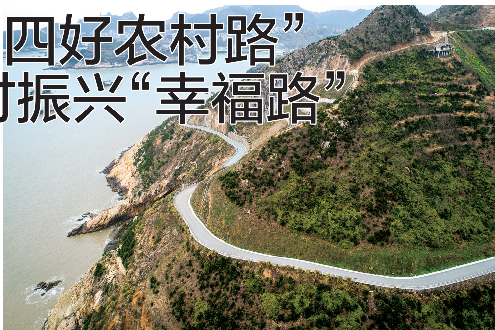
温岭市坞根镇西山下至坑潘段农村公路。
