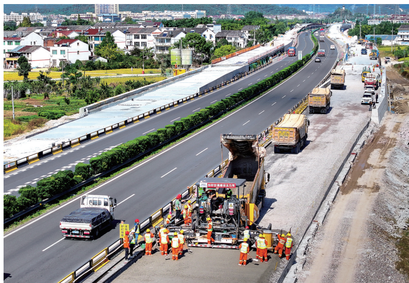
甬台温改扩建台州北段月底新老路段交通转换
