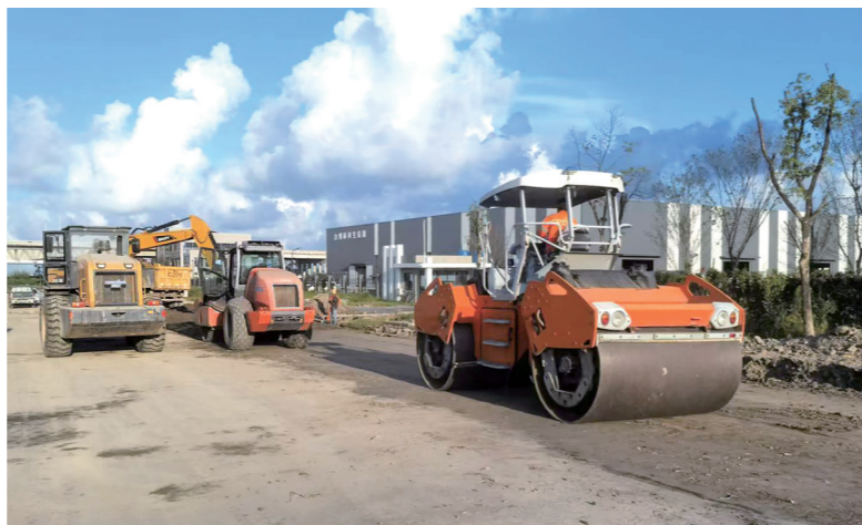
市再生资源公司一期厂区外圈道路施工即用建筑渣土再生固化土混合料。
