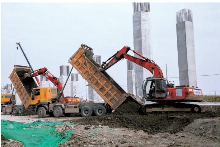
建筑渣土再生固化土混合料被运到市域铁路S2线施工现场。
