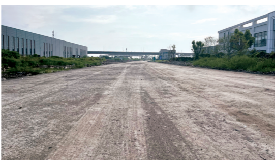
用建筑渣土再生固化土混合料铺成的道路。
