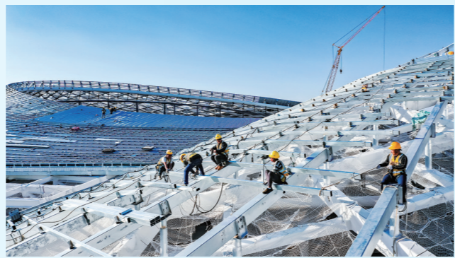
新航站楼屋顶施工
