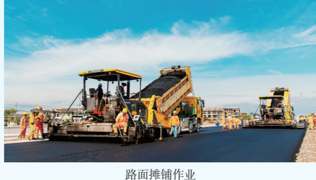
路面摊铺作业
