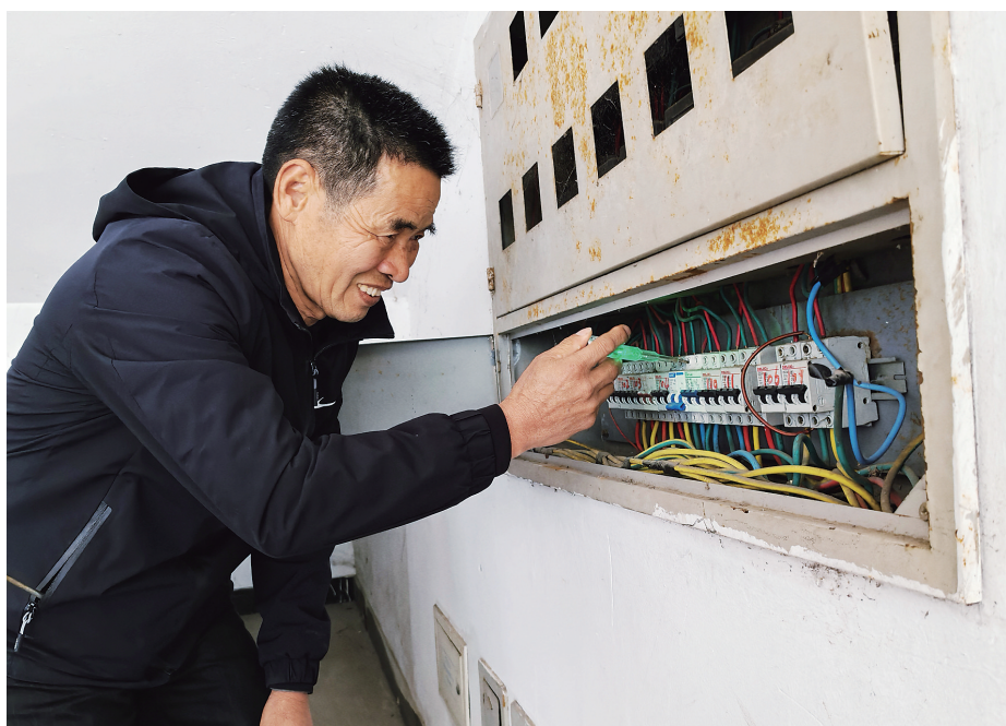
张福平在下园老年公寓检查线路。
