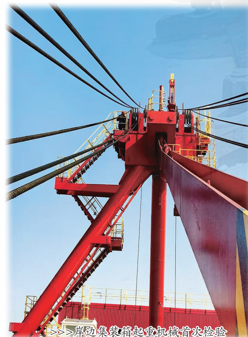
市特检院特种设备检验人员正在对大型起重机械进行检验。
