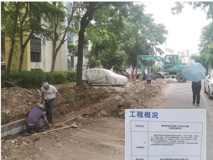
▲小区内正在施工
