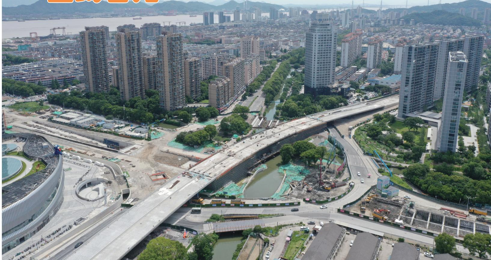
6月29日,随着连接第一联与第三联的第二联边跨最后一段顶板混凝土的浇筑,椒江葭沚转盘82省道跨线桥全线贯通进入最后的“倒计时”。葭沚转盘跨线桥全长410米,分三联施工,其中第二联长度为170米,全线合龙意味着整个桥梁主体结构完成,接下来将进入桥面铺装、防撞墙、标志标线等附属工程的最后冲刺阶段。
