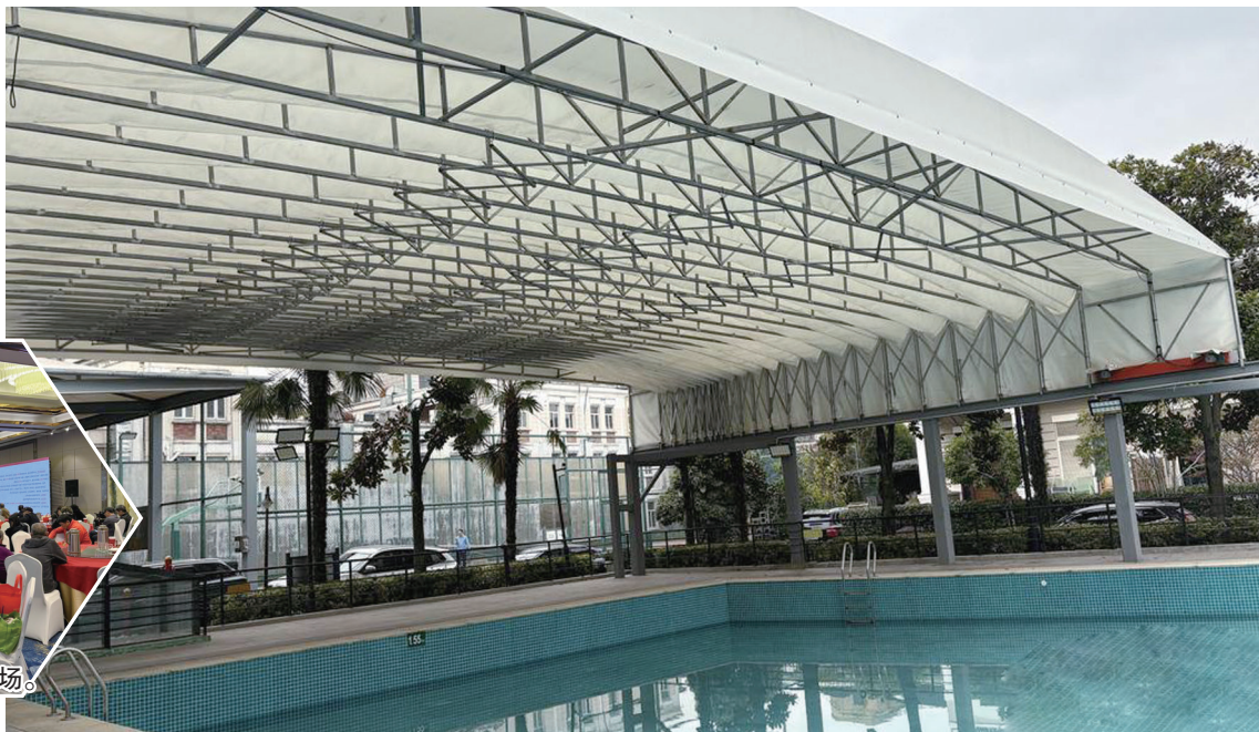
小区泳池上方,业委会加盖了顶棚。
