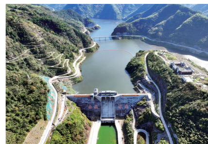
>>>国家172项重大水利项目——朱溪水库下闸蓄水
