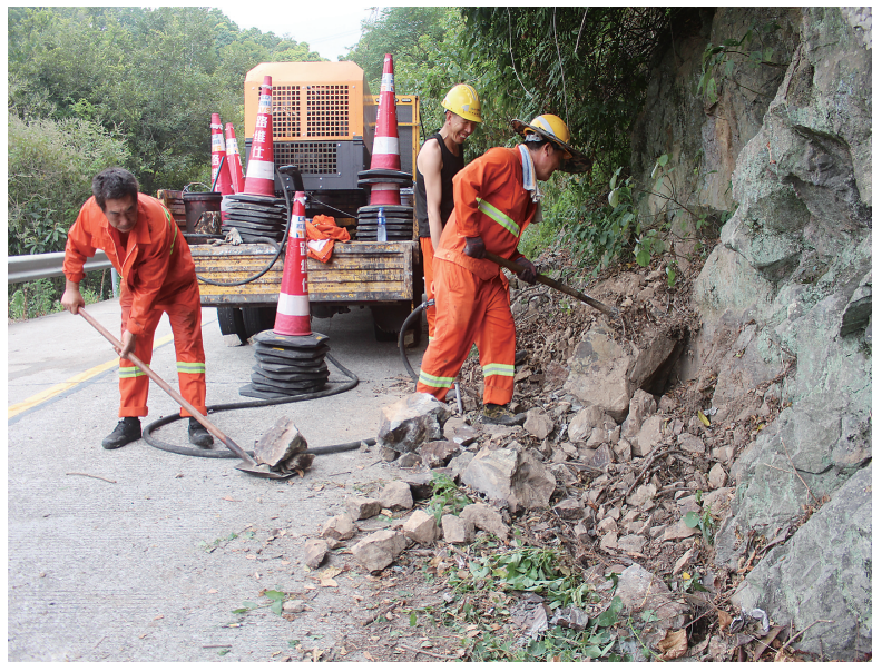
清理沟渠助防台
