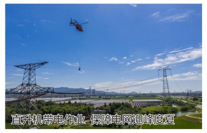
7月24日,在浙江湖州市长兴县吕胥线附近,一架直升机运送带电作业人 员至超特高压线路检修点作业(无人机照片)。
